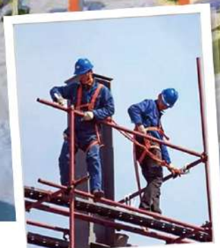
工地安全 (珠海建安集團 / 香洲區應急管理局)
